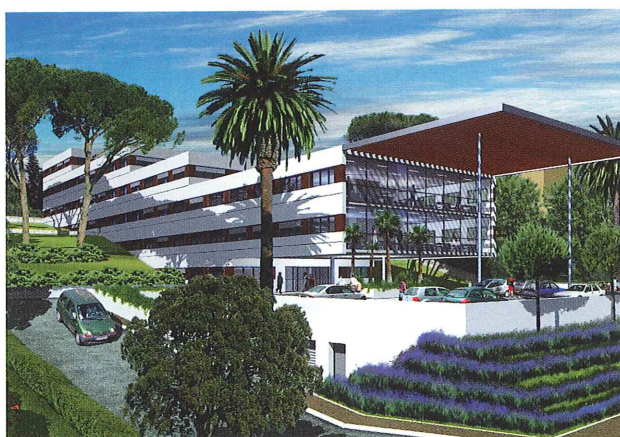
Le parc Euromédecine n'accueille pas seulement des entreprises à vocation médicale. La Direction du Système d'Information et de l'Informatique du Courrier (DSIIC) de La Poste regroupera prochainement ses activités dans ce bâtiment de 3 300 m 2 .
